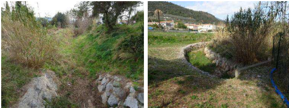
Figure 90 - Canal des Iscles en limite Ouest © EGIS 2019
